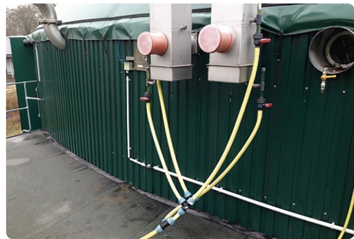
Zeitintensiv: Das tägliche Nachfüllen von Betriebsstoffen einer Biogasanlage.
