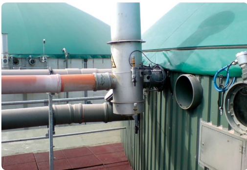
Risiko: Durch hohes Gewicht kommt es immer wieder zu Gasleckagen im Anschlussbereich.
